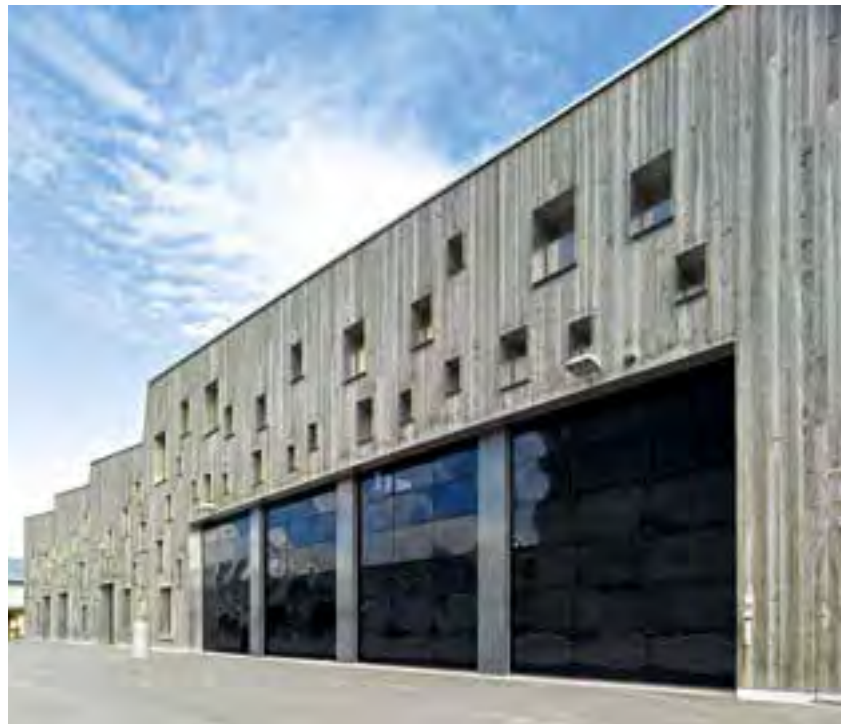
OBEN. ALR F42 mit flächenbündiger Beplankung aus Aluminium-Verbundplatten (bauseitig)
